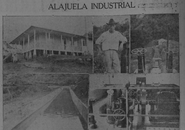
Elegante edificio construido especialmente para el jefe de la planta eléctrica. El primer maquinista, señor Sánchez, que es un excelente experto en materias eléctricas. Los dos tubos de acero que se desprenden del tanque de presión y suministran el agua necesaria para servicio de las turbinas. Un aspecto del acaudado al salir de la presa. Aspecto que presenta el conjunto de las dos turbinas.
